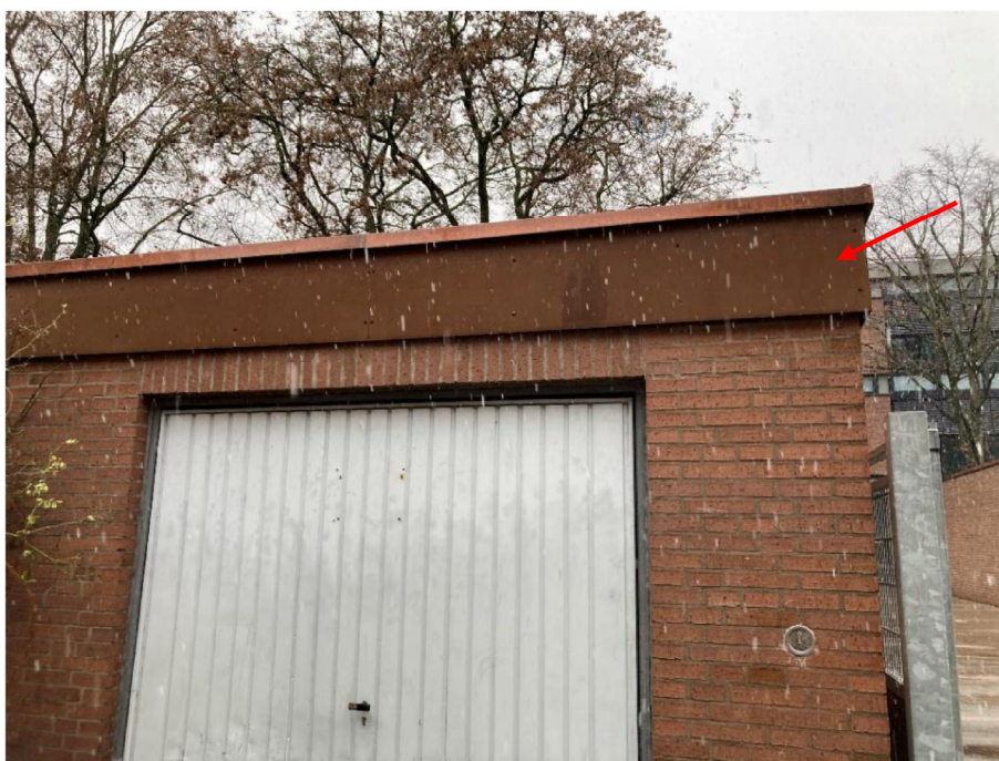
Bild 20 0382-1876 Garage, Asbestzement-Attikablende Nr. 25-02663
